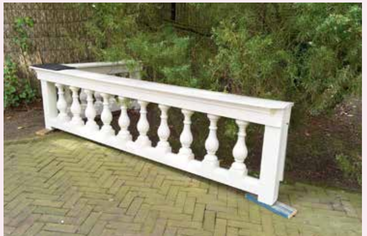
Het gerestaureerde hek van het balkon.
