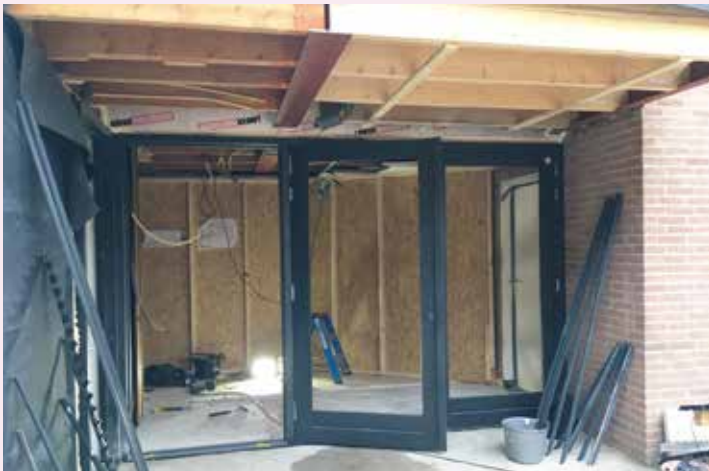
De verbouwing van de hoofdingang.
